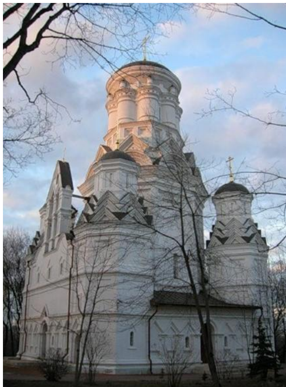
Церковь Усекновения Главы Иоанна Предтечи в Дьякове, Москва. Строительство - между 1529 и 1580 гг.
